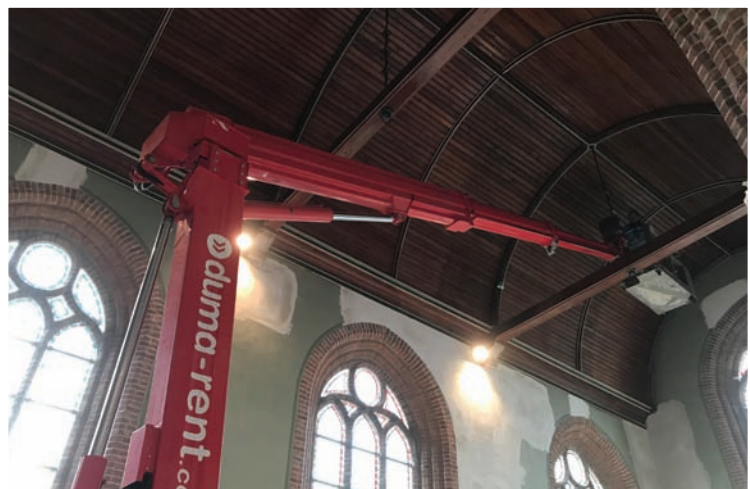
Duma @ Brussel, renovatie van binnendak in kerk
