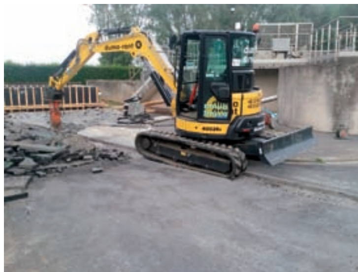
Duma @ Kortrijk (BE) demolition job / YANMAR VIO 57
