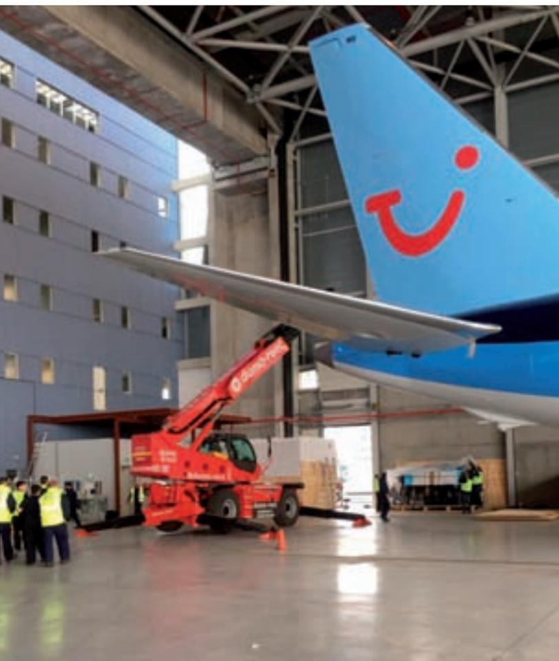
Récemment une compagnie aérienne a installé un nouveau simulateur de vol pour un BOEING B737 à l'aéroport International de Zaventem. La taille et le poids du simulateur ont imposées de louer notre Hyster HX16M-1200. Ainsi il était possible de lever le simulateur à sa plateforme. Le simulateur consistait en deux parties, la cabine et sa couverture.
