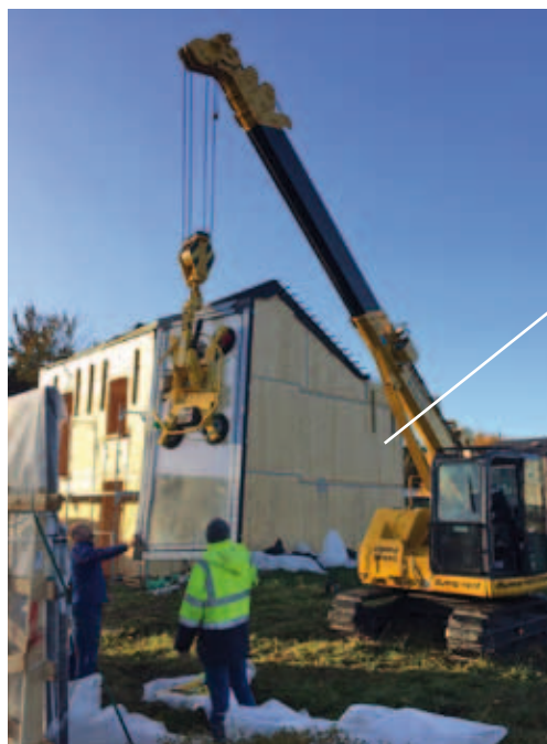
Glasplaatsing @Sint-Amands / MAEDA CC985 + POWR-GRIP 635 kg
