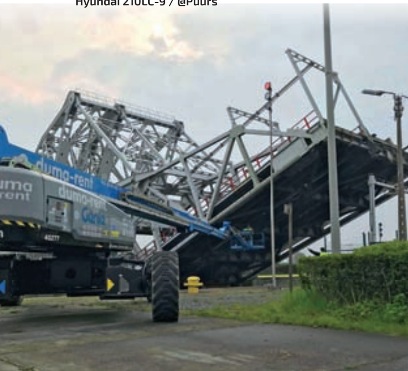
Genie SX135XC - Travaux a un pont-écluse / @Zeebrugge
