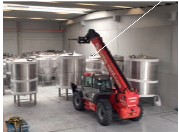
Manitou MT1840P - Construction d'une nouvelle brasserie / @Gand
