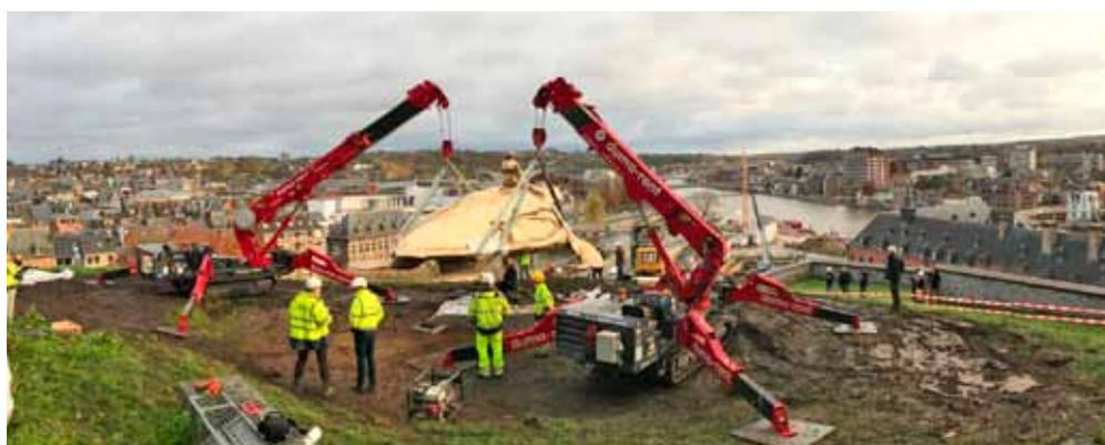
**2x UNIC 706 / Capacité de levage 6T sur 3 m / Hauteur de levage de 18.5 m**
