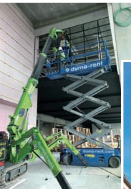
UNIC URW-295 ECO & Genie GS2032 placement du verre antifeu @Kuurne
