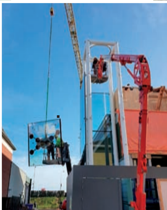
UNIC URW-295 ECO & Genie GS2032 placement du verre antifeu @Kuurne
