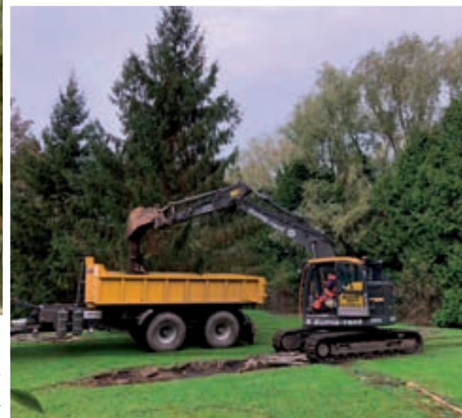
VOLVO ECR145EL @Pont à Vendin (France) Démolition d'un terrain de mini-golf
