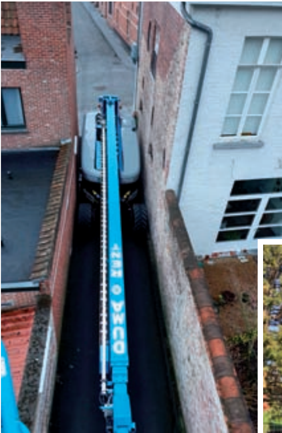
GENIE SX135XC @Bruges Travaux de peinture sur une cheminée
