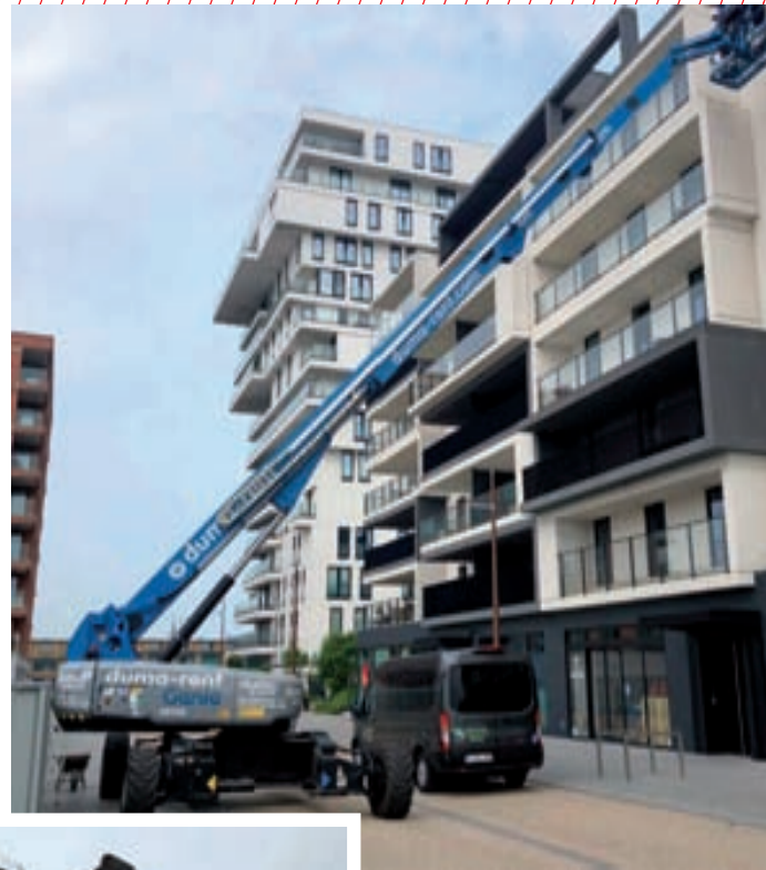
GENIE SX105XC @Oostende Travaux de peinture de nouveaux appartements
