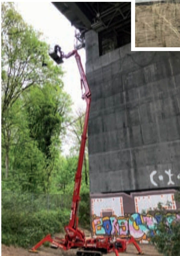
CMC S32 @Vilvorde Travaux sur un viaduc
