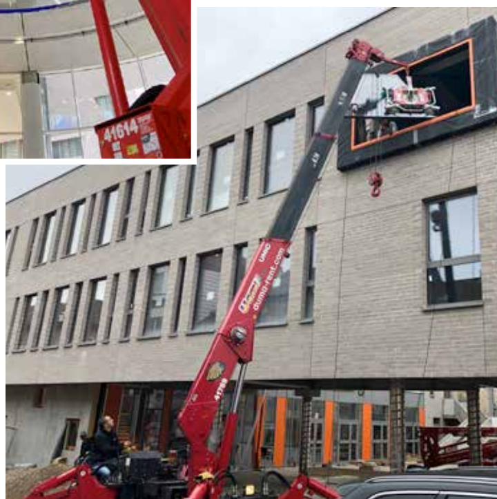
UNIC URW506 @ Brussel Glas plaatsen
