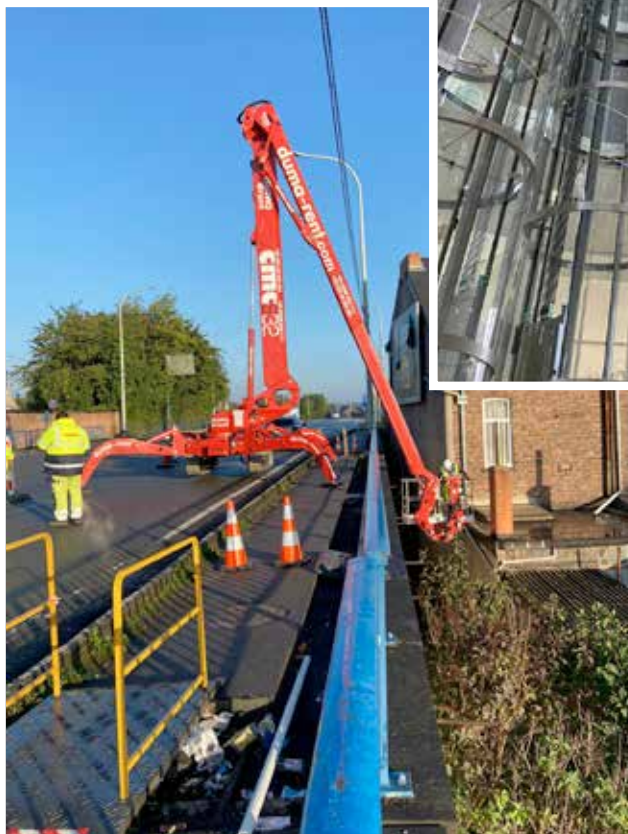
CMC S32 @ Pont du Châtelet Brug inspectie
