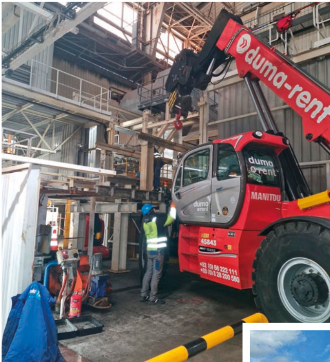
Manitou MHT 10230 @Cuffier (Frankrijk) Installatie productielijn
