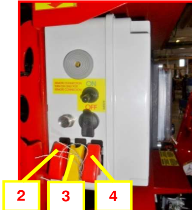
Figure 5 : côté gauche du boîtier électrique.
