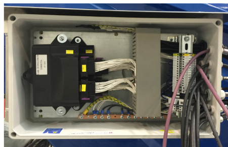
fig. 2.10.10 Transducteurs d'angle jib
