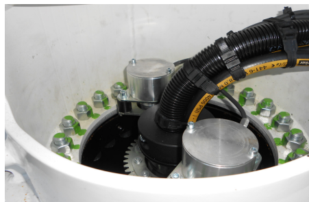
fig. 2.10.8 Capteurs de rotation
